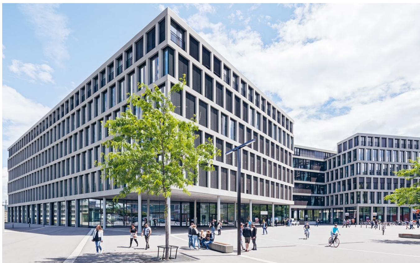
FHNW Campus Brugg-Windisch: Hauptsitz der Fachhochschule Nordwestschweiz.
