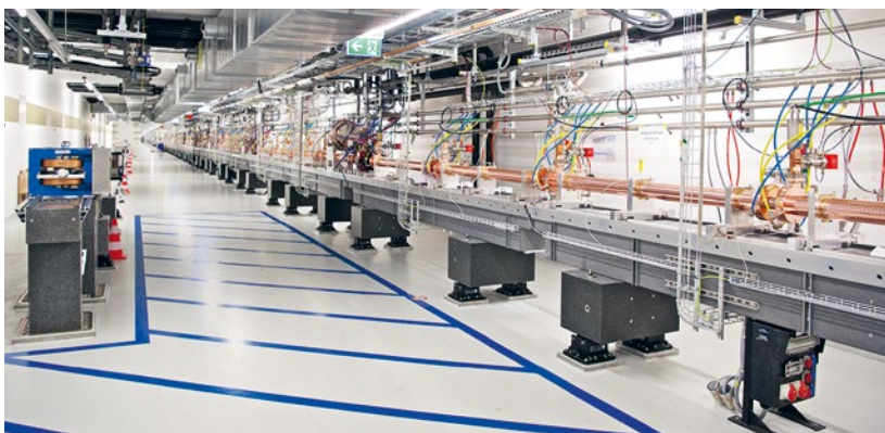
Der Strahlkanal der neuen Grossforschungsanlage SwissFEL: Die Gesamtanlage ist 740 Meter lang.
