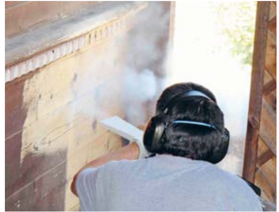
Die Technik des Trockeneisstrahlens ermöglicht eine sanfte Reinigung, beispielsweise von Holzoberflächen.
