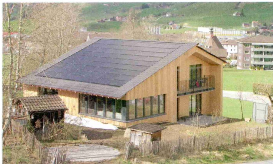
HEV-Sondersolarpreis: Die 17.8 kWp starke PV-Anlage produziert rund 16'600 kWh/a.
